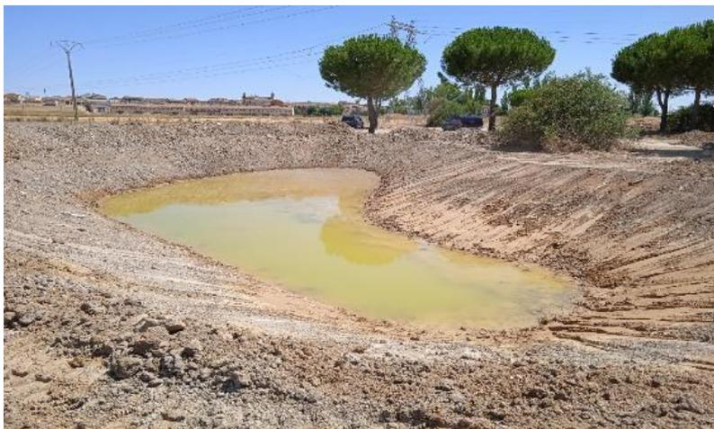
*47 - Resultado final del vaciado y movimiento de tierra*
